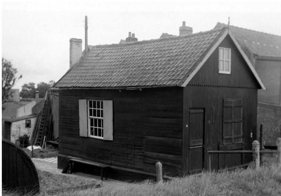
Houten woning van Odiel en Liza aan de Brugsevaart nr. 10. Naast de barak was er een brede gemetste schouw opgetrokken. Dat verzekerde een veilige aansluiting voor de Leuvense stoof. AR
