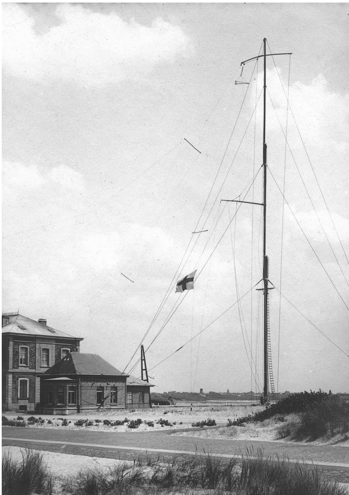
Het kuststation Nieuwpoort, met bijgebouw. De radiomast werd ook gebruikt voor het ophangen van loodsseinen.
