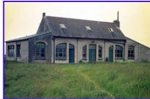
Ontvangststation en kuststation te Stene 1932-1940 en 1945-1964
