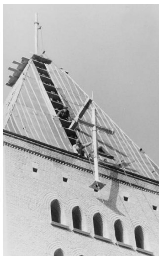
Afb. 219. De houten hulpmast op de torenspits draagt de katrol waarover de hijskabel loopt.
