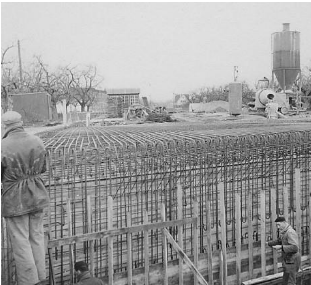
Afb. 363. Halen. De overbrugging van de Gete en de Velp.
