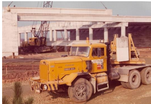
Afb. 480 en 481. Uitzonderlijk transport van de prefabbalken vanuit Lier.
