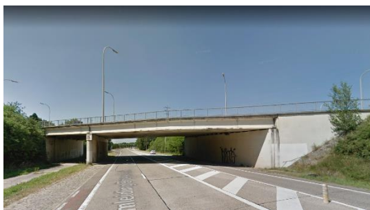
Afb. 488. De brug in 2018.
