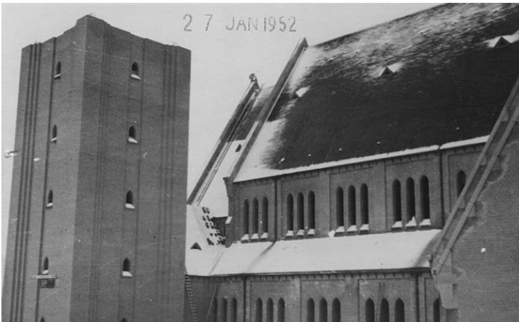
Afb. 200. Midden december 1951 start een sprookjesachtige maar strenge winterperiode. De werf zal hierdoor bijna 3 maanden stil liggen. De verdubbeling van de koperprijs leidt tot de wijziging van de goten en afvoerpijpen uit zacht koper 2mm naar 1mm gehard koper tegen een meerprijs van 23.000 frank.
