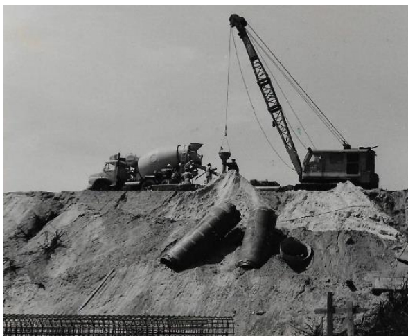
Afb. 471. 24 boorpalen met een diameter van 130 cm en een diepte 20 meter worden door onderaannemer Mast GmbH uit Langenfeld (D) uitgevoerd.
