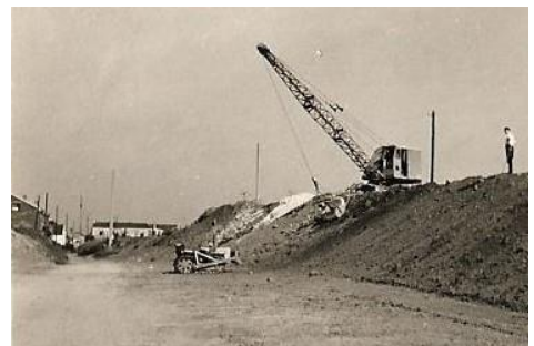
Afb. 359 en 360. Grondwerk voor de toegangsweg met een DAF 4x4, een lichte kraan LAG, een zware dragline en een kleine bull Bristol.
