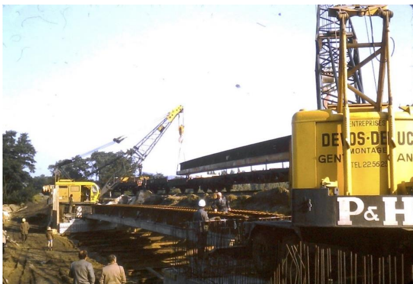
Afb. 473. De via het spoor aangevoerde preflex- liggers worden op een zondagmorgen op de landhoofden ge- legd.
