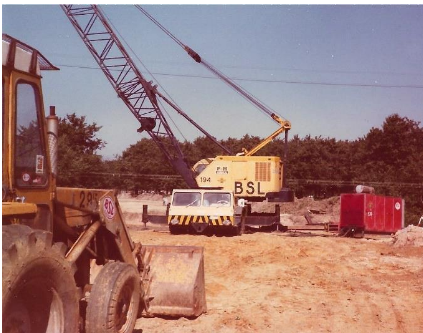
Afb. 507. Collega-aannemer BSL komt de damwanden heien langs het spoor. Dit laat toe de funderingszolen veilig uit te graven.
