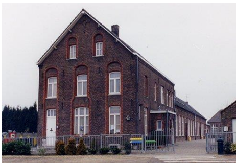
Afb. 20 Het klooster te Dorne, As. Gebouwd voor rekening van de eerwaarde zusters Jozefienen uit St Niklaas- Waas voor de som van 110.735 frank. Onderaannemers waren Hendrik Baudoin, meester-metselaar uit Neerglabbeek en Lowijs, stukadoor uit Asch, die 2,50 frank per m 2 ontving voor zijn plafonneerwerk .
