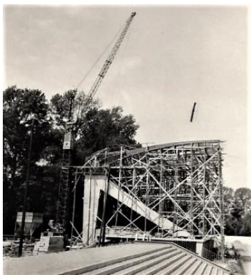
Afb. 316 en 317. Een immens houten timmerwerk ondersteunt de bekisting van het dak.
