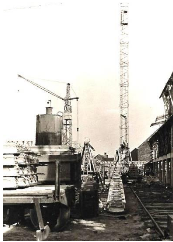
Afb. 378. Montage van de torenkraan op rails.
