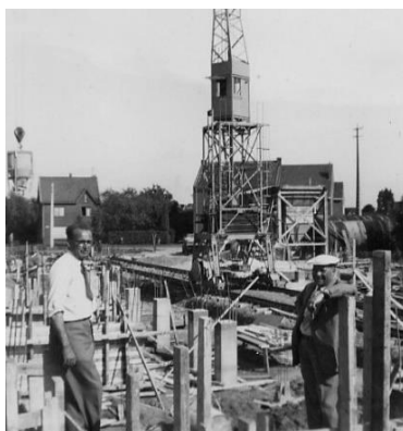
Afb. 294. De werfleider samen met Albert Steyfkens bij de paalfunderingen.
