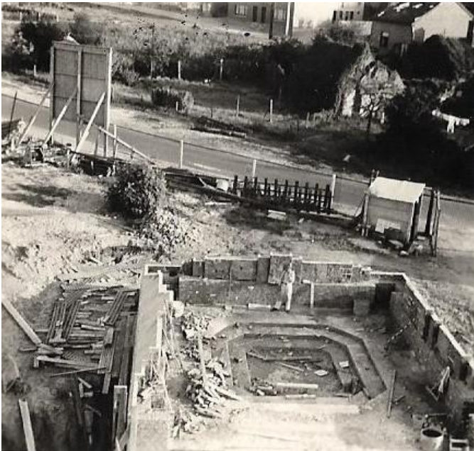
Afb. 133. De basis van de toren met uitdieping voor de doopvont. Links kijken we op de rug van het werfbord. Rechts zien we de werfingang kant Berglaan.
