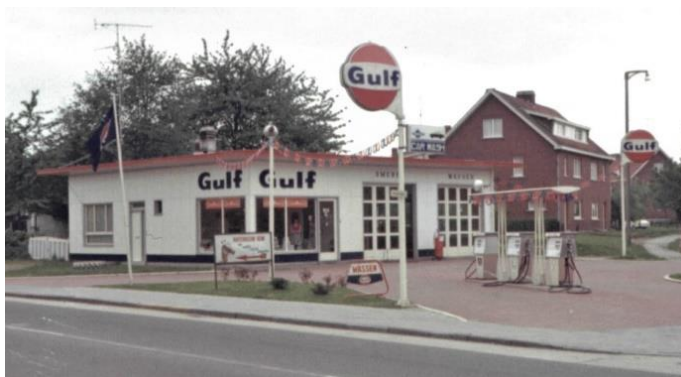
Afb. 394. Het Gulf service station te Genk, hoek Hoogstraat-Kempenlaan.
