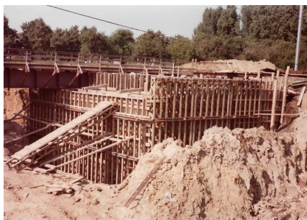
Afb. 503. De nieuwe landhoofden (hier kant Hasselt) worden deels onder de voorlopige brug gebouwd.
