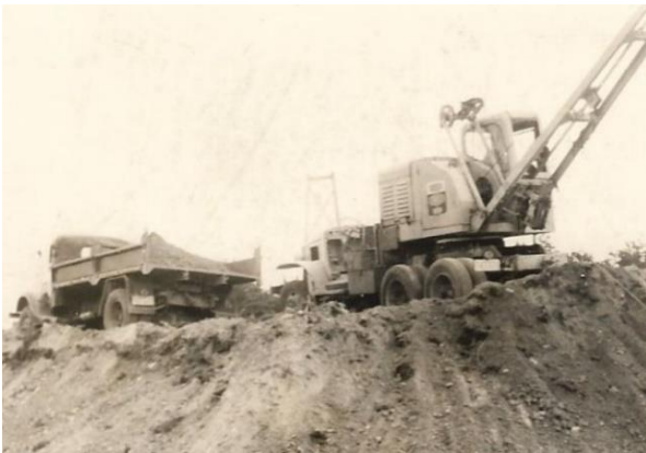
Afb. 242. Grondwerk met de nieuwe Nordest kraan.
