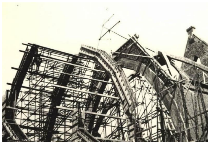
Afb. 174 t/m 177. De bekisting voor het sluitstuk van de kruisboog komt eerst. Dan volgen de kruisbogen.
