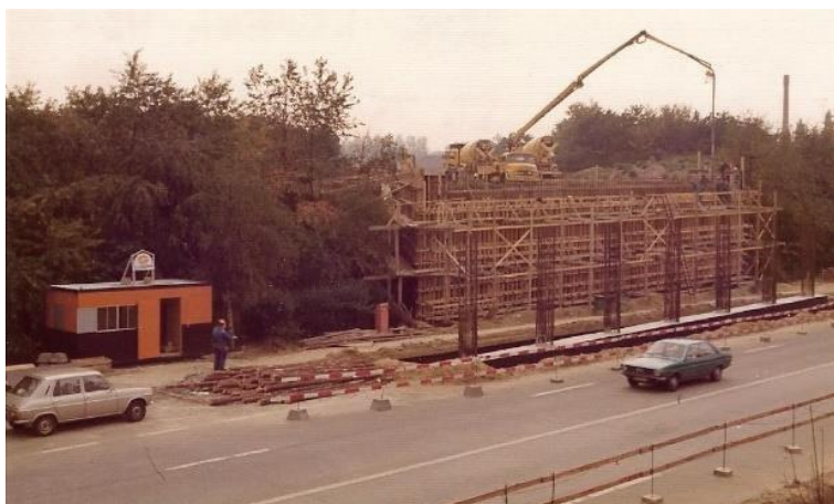
Afb. 487. Het landhoofd kant Zuid wordt gebetonneerd. Tijdens de grondwerken vooraf was uiterste voorzichtigheid geboden om een ondergrondse Nato-verbindings- kabel niet te beschadigen. Rechts op de achtergrond de schoor- steen van het vilbeluik. Zie kader.
