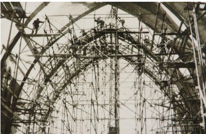
Afb. 182 en 183. Steigerbouw. Een behoorlijk stuk acrobatie op de werf. De hoogtevrees bleef aan de grond, zeiden de moedige monteurs.
