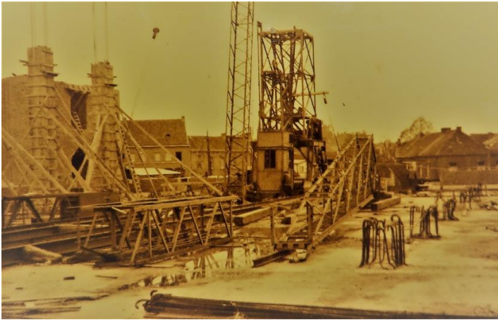
Afb. 131 en 132. De firma Savelkoul uit Bree demonteert de bouwkraan op het niveau crypte en monteert hem opnieuw op de kerkvloer. De giek dient in de montagefase als derrickkraan. Het geheel nam 4 dagen in beslag. Links in beeld de eerste kolombekistingen en daarachter de toren die reeds zijn eerste verdieping bereikt. Op de achtergrond links de Hoogstraat, rechts de Stationsstraat.
