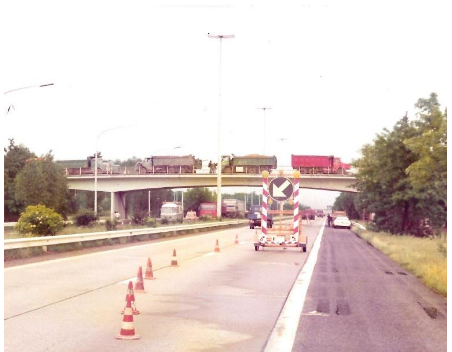
Afb. 485. Brug B55 van de E313 wordt getest.
