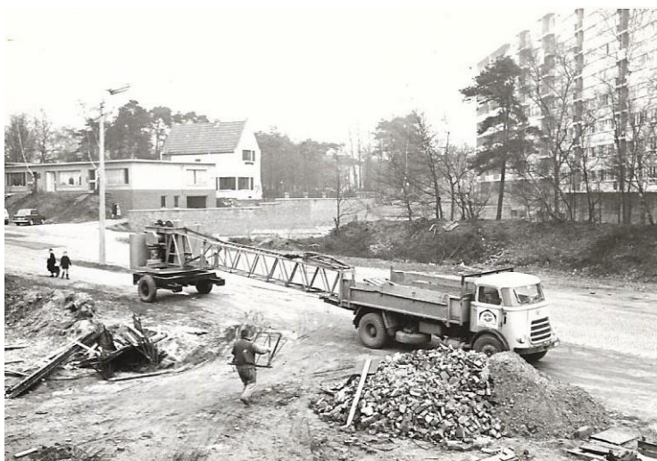
Afb. 404. Aanvoer van de bouw- kraan voor de werf Notariaat Fagard.
