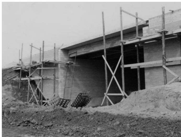
Afb. 358. Zichtmetselwerk van de keer- muren.
