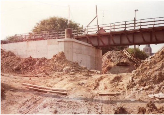
Afb. 504. Het landhoofd kant Leuven is klaar om het dek te ontvangen. Later zullen de muren nog met gevelstenen worden afgewerkt.
