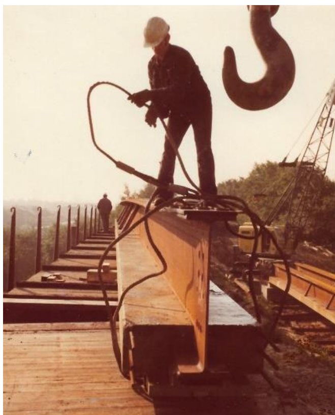
Afb. 474. In de ochtendzon van oktober 1974 slaat een rigger één van de 3 liggers aan.
