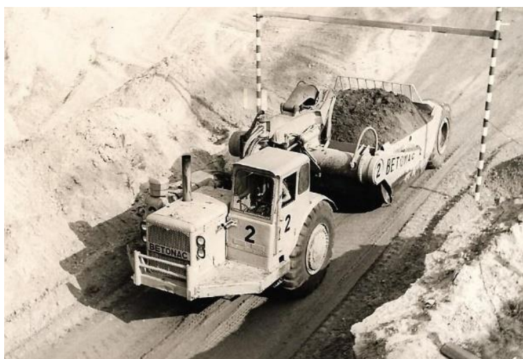
Afb. 432. Brug B18. We zien een Caterpillar-scraper van Betonac uit St Truiden, de aannemer van de grond- werken, die hier onder de in aanbouw zijnde brug gaat doorrijden. Omdat de trillingen van het transport schade konden veroorzaken aan het uithardend beton van de brug was een snelheidbegrenzing van toepassing voor de 80t zware transporten.
