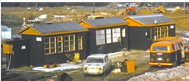
Afb. 453. De werfketen aan brug B15.
