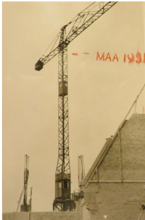
Afb. 166 en 167. De verbinding met de toren wordt met dakpannen bedekt. De kraan met 2 cabines.
