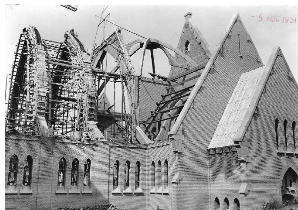
Afb. 197 en 198. Terwijl de kraan langzaam achterwaarts over de rails opschuift wordt op de zijbeuken de dakbebording gestart.
