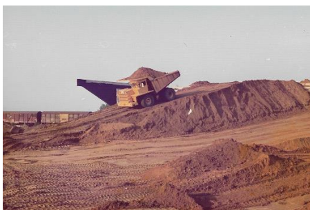
Afb. 484. Grondophogingen aan de westzijde van de brug.
