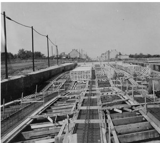
Afb. 343. Brug B54 te Paal. Bekisting en wapeningsstaal van het brugdek. Brug B53 was smaller dan de naastliggende B54.
