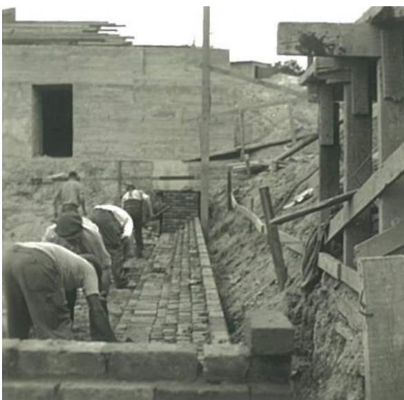
Afb. 122 en 123. Funderingen uit beton en metselwerk. Een Westvlaamse ploeg van 8 metselaars met Herman Coppens als ploegbaas.
