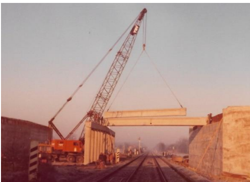
Afb. 482. Op de winterse zondag 9 februari 1975 werd het spoorverkeer onderbroken om de 40 prefabliggers te monteren. Tijdens de nacht na de montage werden van de vrachtwagens 22 wielen gestolen.
