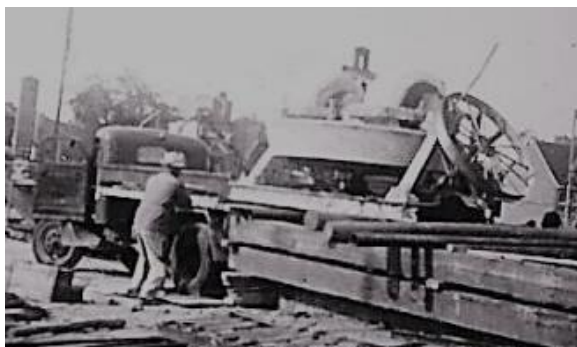
Afb. 114. Voor de funderingen, volgens plannen van Franki, werd in het beton gebroken puin gemengd. Dit gebeurde in een "broyeur", een breek- en menginstallatie bediend door oude rot in het vak Jo Aerts. Jo werkte eerder nog op de werf van Albertkanaal in aanbouw.
