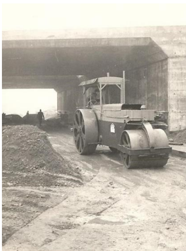
Afb.421. Wegeniswerken onder de brug. We zien een wegenwals van het merk Huber (ex-legermateriaal).
