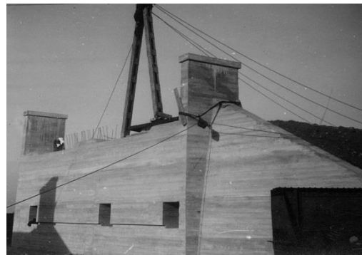
Afb. 37 Een voltooid landhoofd met Derrickkraan bovenop.
