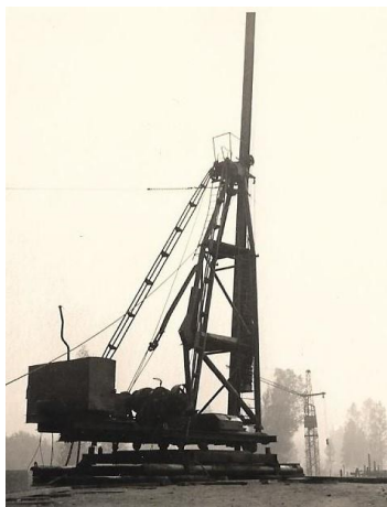
Afb. 338. Brug 43. De heistelling die werd gebruikt om de ter plaatse gemaakte funderingspalen te heien, hier gefotografeerd op een winterochtend. Op de achtergrond de kraan aan het andere landhoofd.
