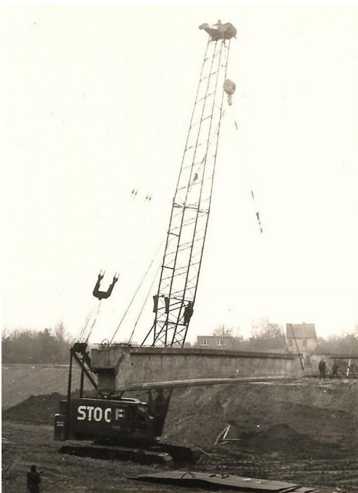
Afb. 447. Vier 34 m lange balken van elk 50,5 ton werden ter plaatse geprefabriceerd en met een rups-kraan van kraanbedrijf Stoof uit Nederland rijdend gemonteerd in januari 1972. De kraan was met zes transporten in delen aangevoerd vanuit Breda en op de werf samengebouwd.
