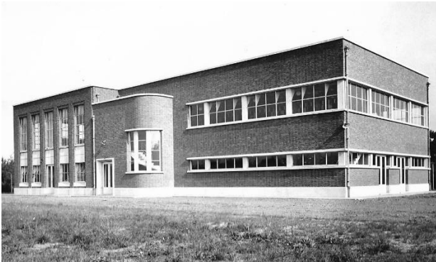
Afb. 264. De hoogspanningspost te Beringen, aan de Hospitaalstraat.
