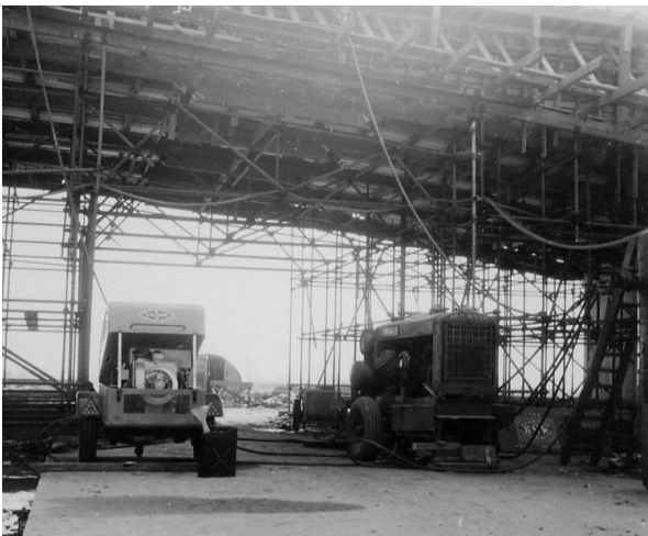
Afb. 354. Brug B51 te Tessenderlo. Twee mobiele luchtcompressoren die de nodige perslucht leveren. De ondersteuning van het dek zijn hier niet uit hout zoals in afb. 339 maar met steigerbuizen gebouwd.
