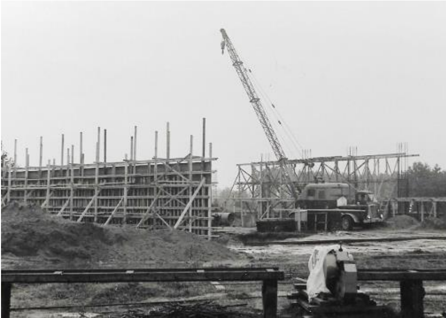
Afb. 479. September 1974. Het landhoofd west en de 12 centrale pijlers zijn in aanbouw. Ondanks een erg nat jaar kon de brug toch nog tijdig afgewerkt worden.
