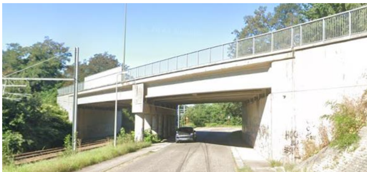
Afb. 501. De brug in 2023 met de verbindingslus van de weg die een conflictvrije verkeerssituatie biedt. De tractie-bovenlijn van het spoor was er in 1979 nog niet.
