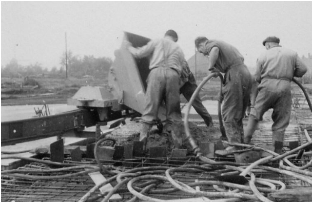
Afb. 347. Het beton wordt tot op de stortplaats gevoerd door een treintje (de Monorail , zie ook afb. 349). De betonneurs spreiden het beton en verdichten het met pneumatische trilnaalden.
