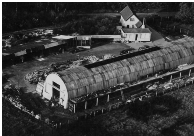
Afb. 256. Luchtfoto van de magazijnen.
