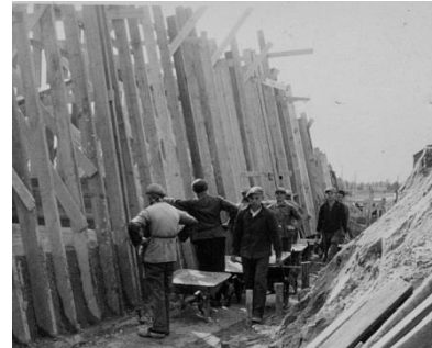
Afb. 35 Achterzijde van een landhoofdbekisting. Grondwerkers op klompen, kruitwagens in de file.
