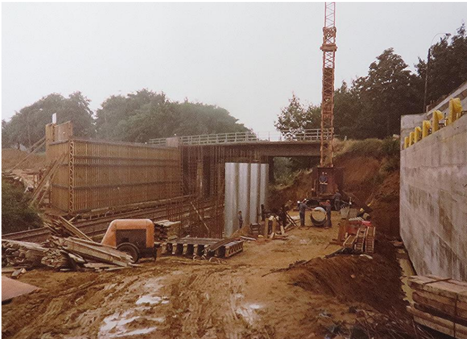
Afb. 498. Op de foto zien we rechts het landhoofd Noord. De zuidzijde staat nog in de bekisting. In het midden de buisbekistingen voor de pijlerrij.
