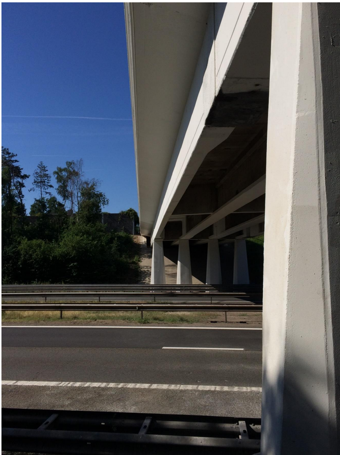
Afb.526. Brug B19 van de E314 in de Mispadstraat te Genk.
