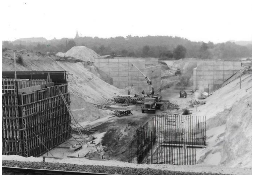
Afb.491. Op de voorgrond R de zool van het zuidelijk landhoofd van de spoor- brug. Achteraan zien we de Tennislaanbrug. Aan de horizon de kerk van Winterslag.
