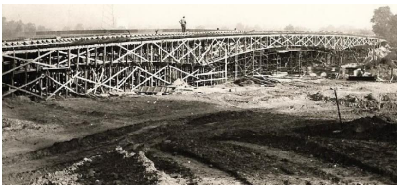
Afb. 431. Brug B18. De grond onder de brug werd voor het grootste deel afgegraven na de voltooiing van de brug.
