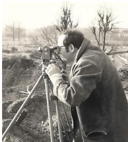
Afb. 427. Brug B18. Conducateur Paul Boes paalt het werk uit.
