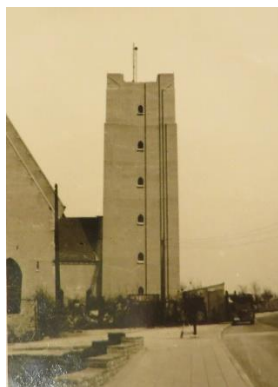
Afb. 213 en 214. Omdat de kraan niet hoger reikte dan de 7e verdieping werd de resterende hoogte gebouwd met behulp van een derrickkraan. Zie ook afb. 241.
