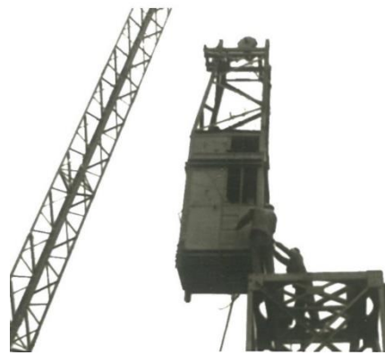
Afb. 131 en 132. De firma Savelkoul uit Bree demonteert de bouwkraan op het niveau crypte en monteert hem opnieuw op de kerkvloer. De giek dient in de montagefase als derrickkraan. Het geheel nam 4 dagen in beslag. Links in beeld de eerste kolombekistingen en daarachter de toren die reeds zijn eerste verdieping bereikt. Op de achtergrond links de Hoogstraat, rechts de Stationsstraat.
