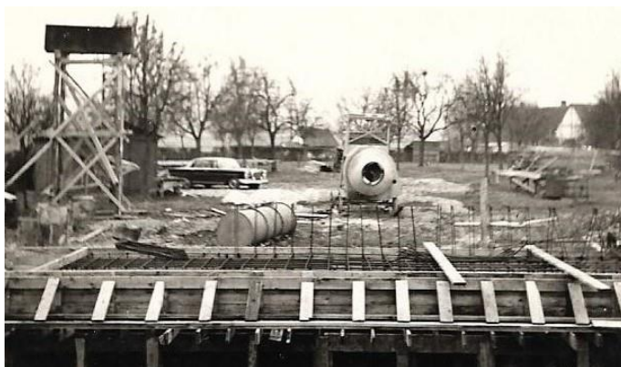
Afb. 366 en 367. Brug B77 te Rapertingen. Ook in Hasselt werden weiden autostrade. De dragline Nordest type 36 graaft de bouwput voor een brugpijler. Een werf midden een erg landelijke omgeving.
