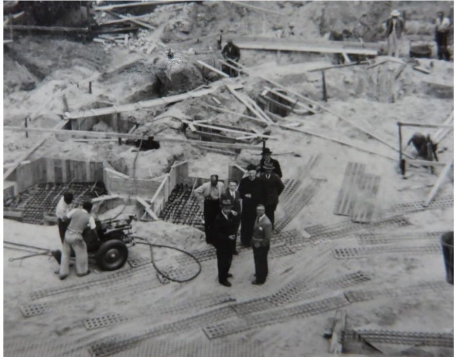
Afb. 121. Werfbezoek met inspectie van de funderingen. Let op de "Amerikaanse" rijplaten (ze werden tijdens de oorlog in elkaar gehaakt om te velde landingsstrips te vormen).
