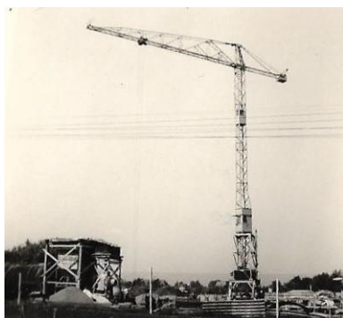
Afb. 292 en 293. Rekem was de derde plaats van inzet voor de kraan Weitz die eerder ook op de werf van de kerk in Genk stond. Het kraan- spoor volgt de lengte-as van de kerk.
