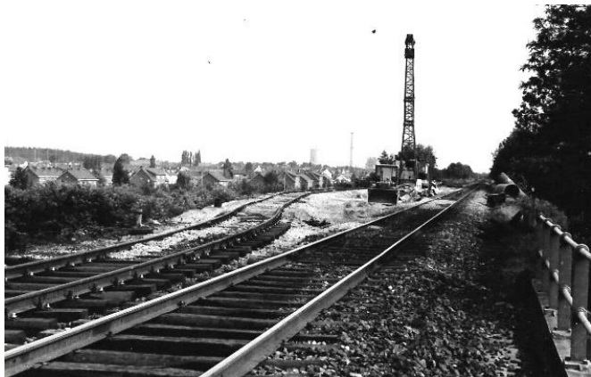
Afb. 470. Om toe te laten de brug te bouwen werd het talud tijdelijk verbreed en het spoor omgelegd in de periode van 11 tot 14 juni 1974.
