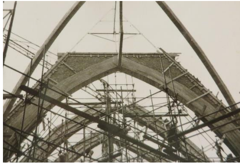
Afb. 180 en 181. Bekisting van de bogen en metselwerk tot aan het dak.
