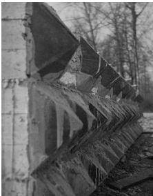
Afb. 314 en 315. Funderingspalen waren een noodzaak, gezien de nabijheid van de rivier Dijle. Hier zien we de ter plaatse gemaakte heipalen en de heistelling van de firma Despriet.
