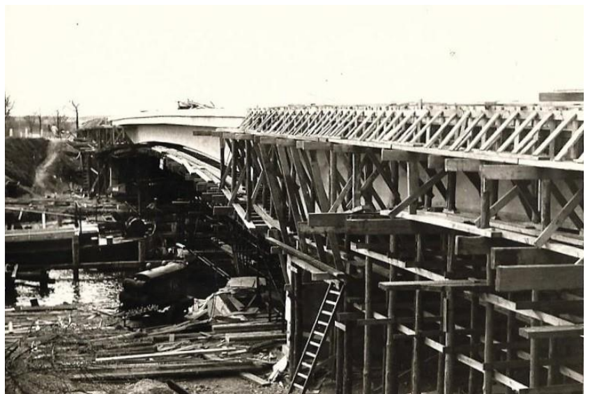
Afb. 388. De voorlopige ondersteuning liet een doorvaarbreedte van 10,50 m toe voor de schepen.
