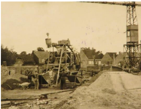
Afb. 120. De werfbetoncentrale.
