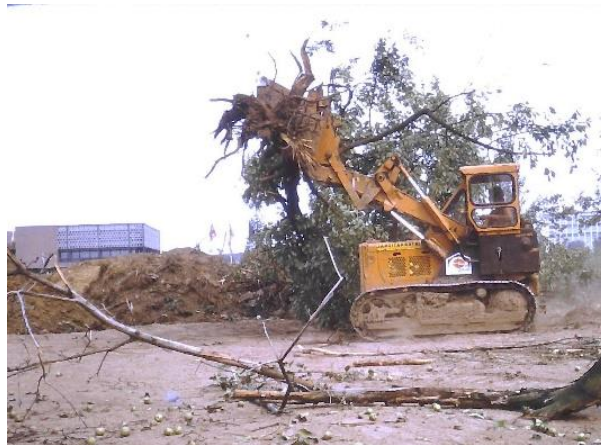
Afb. 461. Bouwrijp maken van het terrein langs de Oude Luikerbaan.
