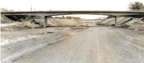
Afb. 436. De brug B18 werd getest op 8 mei 1972. Er trad een maximale doorbuiging op van 17mm.
