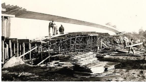
Afb. 433. Brug B18. Ontkisten van het brugdek.
