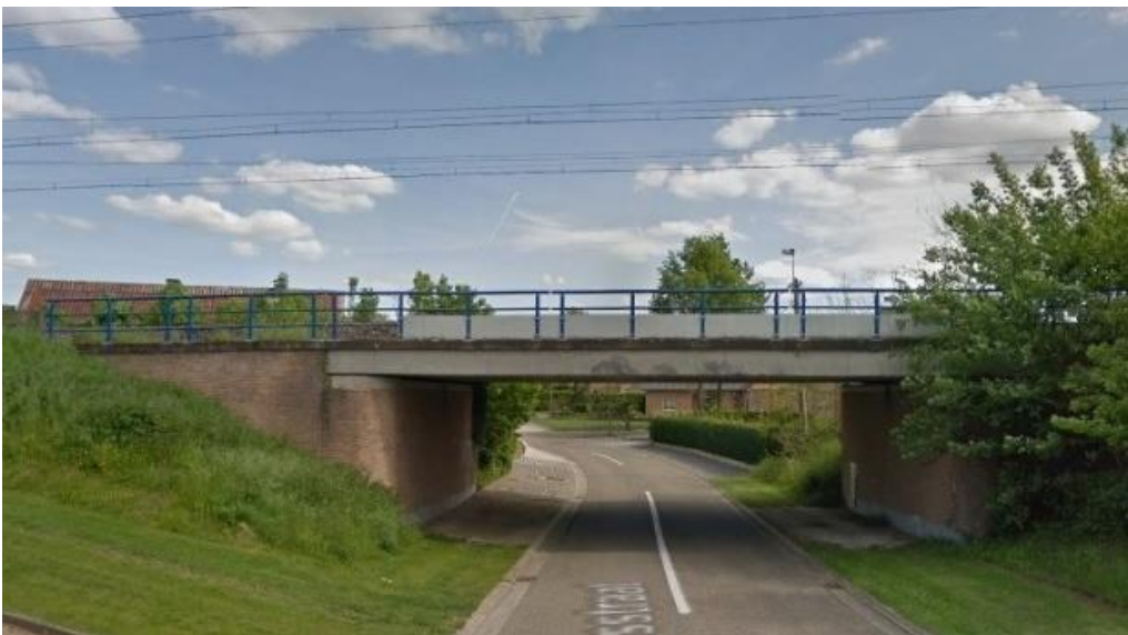
Afb. 506. De brug in 2018.
