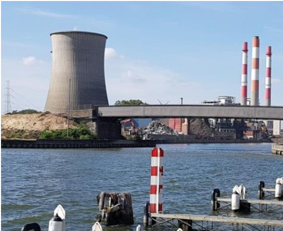
Afb. 283. De brug in 2018. De electriciteits-centrale werd gesloopt in 2021.
