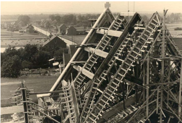
Afb. 298 en 299. Bekisting voor de betonnen dakspanten en gordingen.
