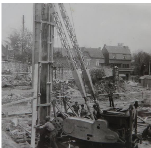
Afb. 105. De heimachine. Omdat het meer dan 2 ton zware valblok zoveel herrie maakt communiceren de machinist en de heimeester via gestandaardiseerde gebaren (zie afb. 106). Na het gieten van een paal en om het verhardingsproces niet te verstoren “wandelt” de machine als een eend naar de volgende locatie. Hiertoe heeft de machine 4 plateauvoeten die afwisselend gehesen en verschoven worden. Reeds in 1924 werden voor de kolenmijn van Zwartberg Frankipalen uitgevoerd, toen nog met een machine met stoomaandrijving.
