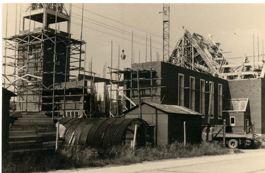
Afb. 295. De metsel- steigers voor toren en voorgevel.
