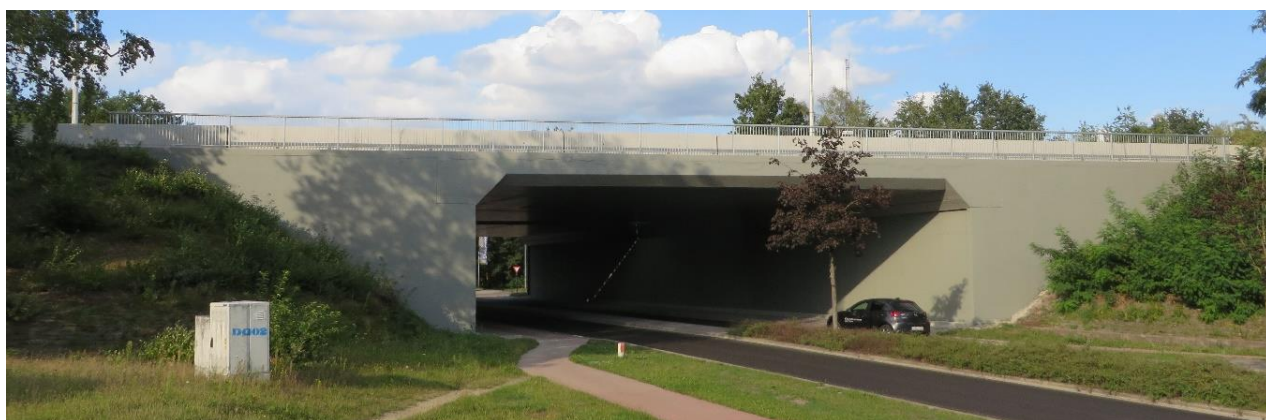
Afb. 425. Brug O17 in 2019, na renovatiewerken. Tijdens deze werken dook nog een op de muren geschilderde politieke boodschap op: “Wet Major”. Een verwijzing naar minister van arbeid Louis Major, die in die tijd een nieuwe havenwet liet goedkeuren.
