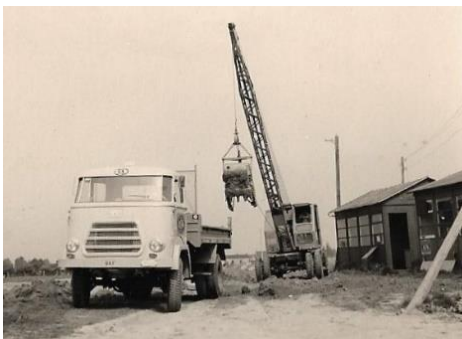
Afb. 359 en 360. Grondwerk voor de toegangsweg met een DAF 4x4, een lichte kraan LAG, een zware dragline en een kleine bull Bristol.
