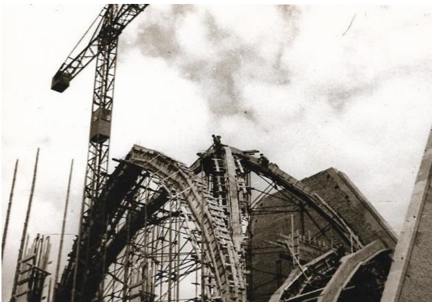
Afb. 178 en 179. Het reigersnest op 22.00 m hoogte is het sluitstuk van de kruisbeuk. De nok van het dak zal op 32.50 m hoogte liggen.
