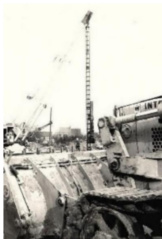
Afb. 429 en 430. Brug B18. De pijlers werden in uitgraving (met als beschoeiing een zo geheten Berliner wand ) gebouwd. Collega-aannemer Louis Mols voerde de heiwerken van de stalen profielen uit. Met de tijdelijke uit-schakeling van een hoogspanningslijn boven de werf.
