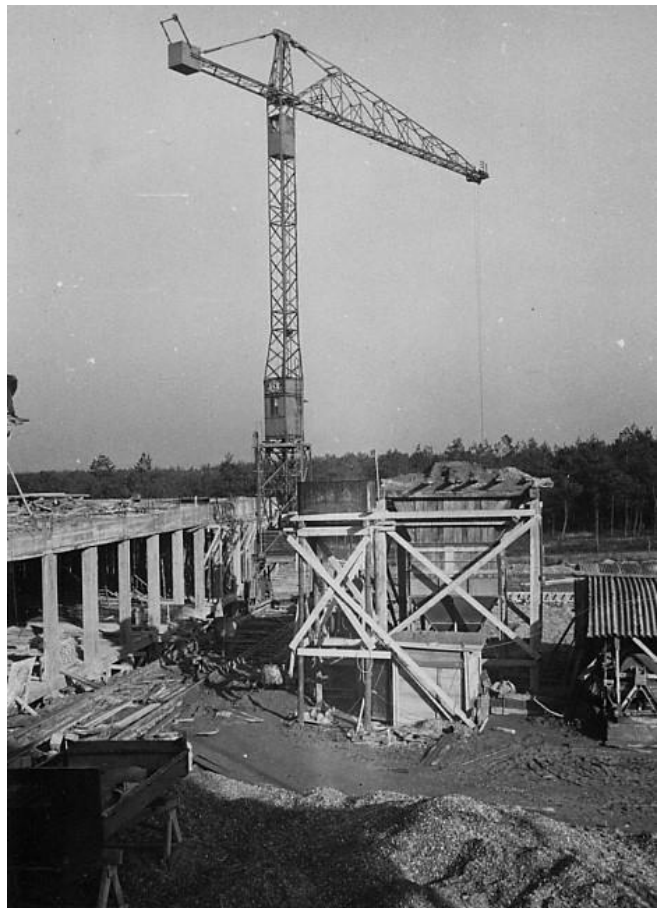
Afb. 243. De kraan en de betoncentrale.
