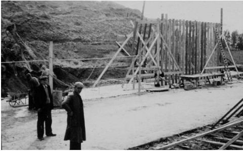
Afb. 34 De bekisting van een landhoofd.
