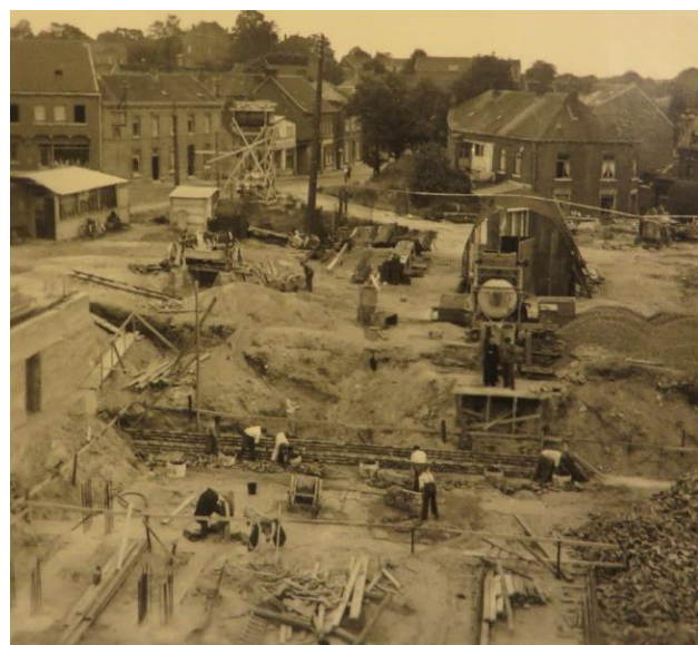
Afb. 122 en 123. Funderingen uit beton en metselwerk. Een Westvlaamse ploeg van 8 metselaars met Herman Coppens als ploegbaas.
