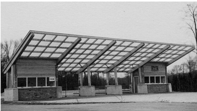
Afb. 320 en 321. Het toegangsgebouw met in de sokkel de in hardsteen gebeitelde naam van de bouwonderneming.
