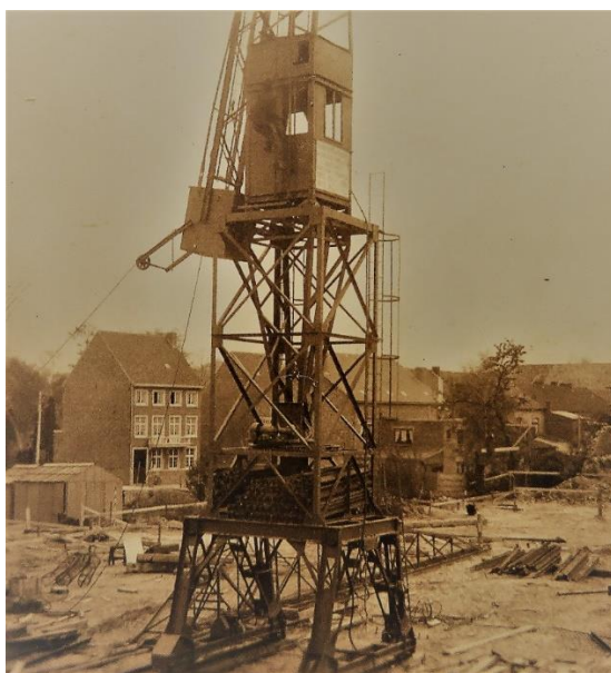
Afb. 115. In April 1950 werd de torenkraan op spoor gemonteerd op het niveau 'vloer crypte'. Op de achtergrond de Molenstraat.
