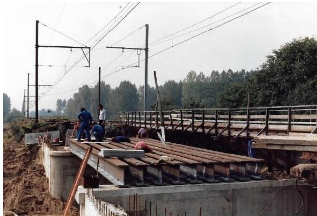
Afb. 505. De 9 stalen liggers voor de rijrichting Leuven (treinen rijden in België links) worden uitgericht. De persoon in het witte hemd ben ik.
