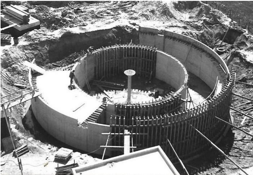
Afb. 494. De 6.10m diepe concentrische kuipen met buiten- diameter 23 m zijn voor de helft klaar.
