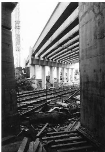
Afb. 499. Na het plaatsen van de prefab liggers. Deze foto werd genomen van onder de oude brug.
