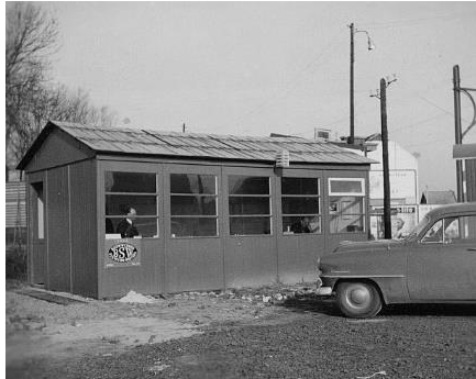
Afb. 319. Het werfbureel. Mijn vader of zijn broer waren dagelijks aanwezig op de werf.
