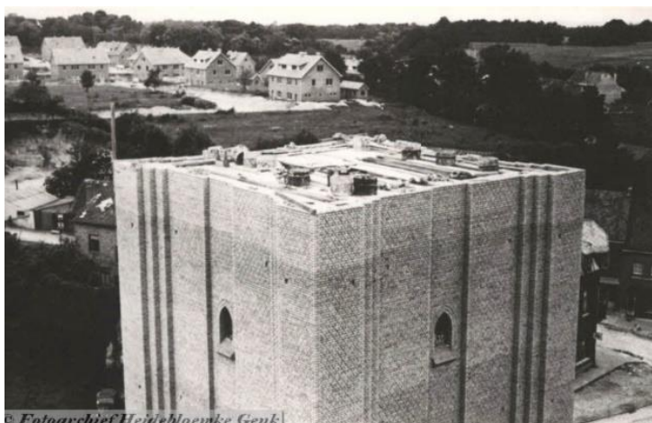
Afb. 212. De toren vlak vóór de demontage van de torenkraan. Randbeveiliging in de bouw was niet echt nodig, zo lijkt het wel ! Op de achtergrond zien we de in aanbouw zijnde woningen van de wijk Vlakveld.
