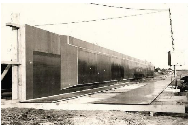
Afb. 445. De bekisting van de balken (lengte 34m) voor de middenoverspanning. Ze werden aan de rand van de werf prefab gemaakt. (fase 5 uit afb. 444)
