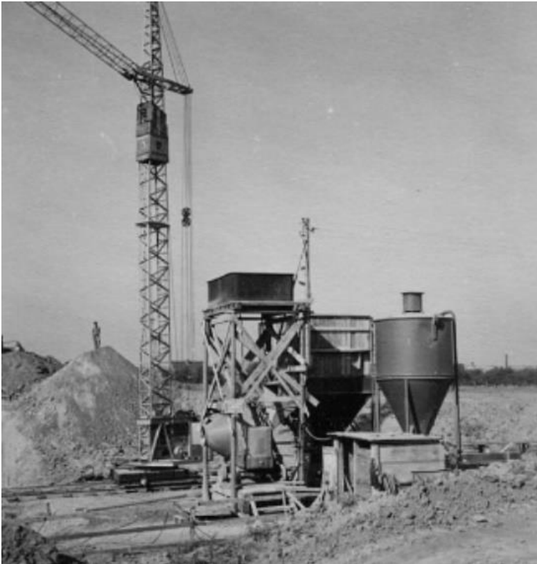
Afb. 357. Rocourt, brug onder de E25. De bouwkraan, rijdend op spoor. De betoncentrale met bovenaan een buffervat voor water.
