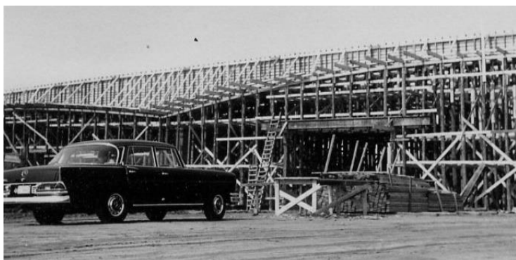
Afb. 368 en 369. Brug B57 te Lummen (Gestel). De bekisting opbouwen vergde ongeveer 1200 werkuren. Op de voorgrond de Mercedes 220S van Albert.
