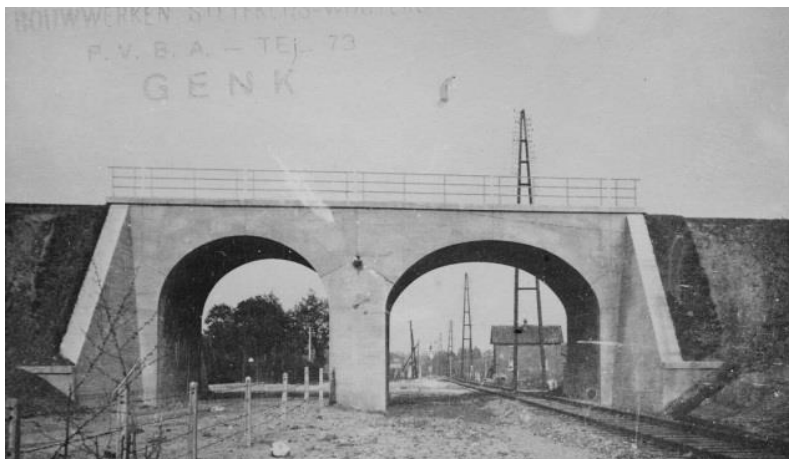
Afb. 38 De brug op de kruising van het spoor Winterslag-Bilzen en het spoor Hasselt-Genk. Links de doorgang voor de Oude Zonhovenweg. De foto werd genomen in de richting Genk. De brug lag ongeveer 80m ten noorden van de huidige brug aan de Hasseltweg.
