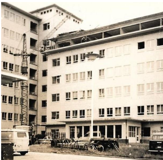
Afb. 407. Vanwege zijn jarenlange ervaring als zaakvoerder van BSW verwierf Louis vlot de nodige erkenningen om publieke werken uit te voeren. Hier de uitbreiding van blok E met een verdieping. Ook in 1969 werd de keuken van het ziekenhuis uitgebreid met ca. 1200 m 2 in 3 bouwlagen.
