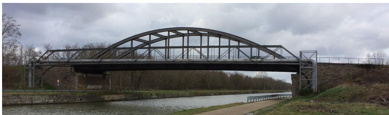
Afb. 282. De brug in 2020. De pijpenbrug werd na 1960 bijgebouwd
