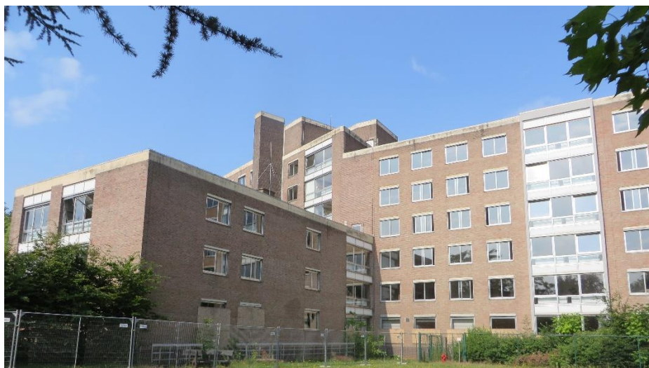
Afb. 463. Het ge- bouw net vóór de sloop in 2019.
