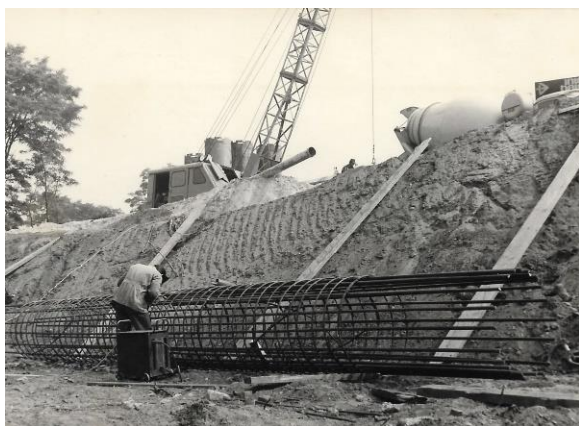
Afb. 472. De wapeningskorven voor de boorpalen worden aan de voet van het talud voorbereid.
