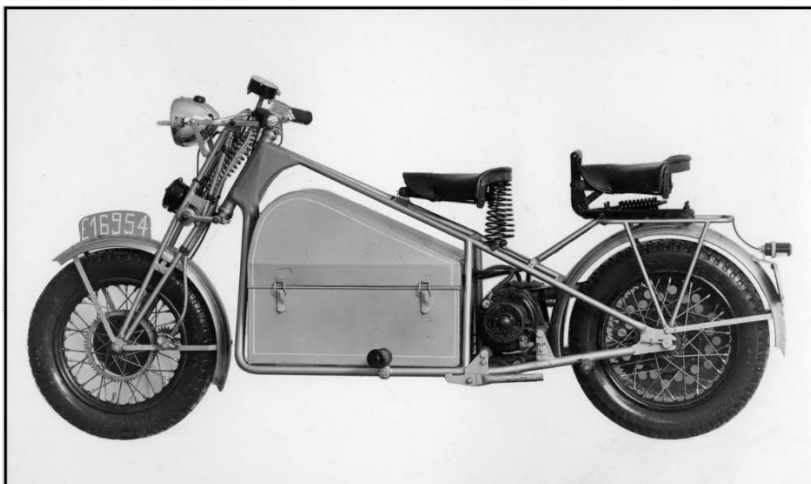
Afb. 79h. De Socovel elektrische motor 18V waarvan sprake op p.24.
