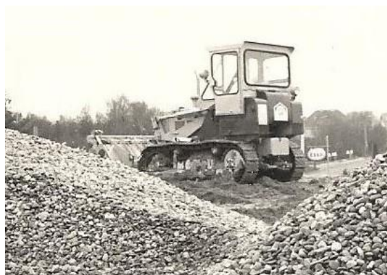
Afb.422 en 423. De achterzijde van de keermuren zijn voorzien van een drainagevoorziening uit holle betonblokken en grind. In de verte zien we het Esso-servicestation van Jean Dubois die later mijn schoonvader zou worden.
