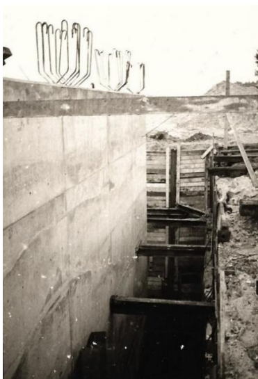
Afb. 429 en 430. Brug B18. De pijlers werden in uitgraving (met als beschoeiing een zo geheten Berliner wand ) gebouwd. Collega-aannemer Louis Mols voerde de heiwerken van de stalen profielen uit. Met de tijdelijke uit-schakeling van een hoogspanningslijn boven de werf.
