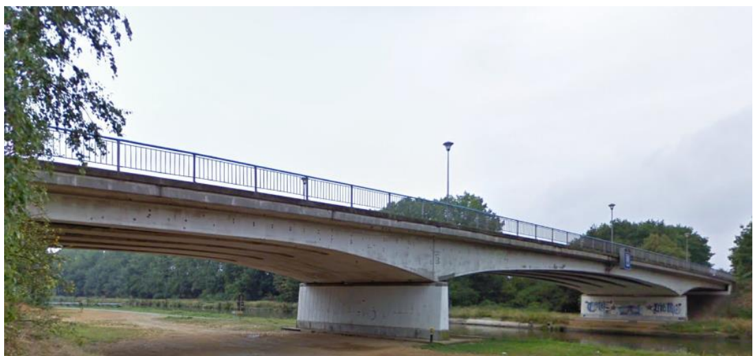
Afb. 391. De brug in Maaseik-Neeroeteren over de Zuid-Willemsvaart (foto uit 2009).
