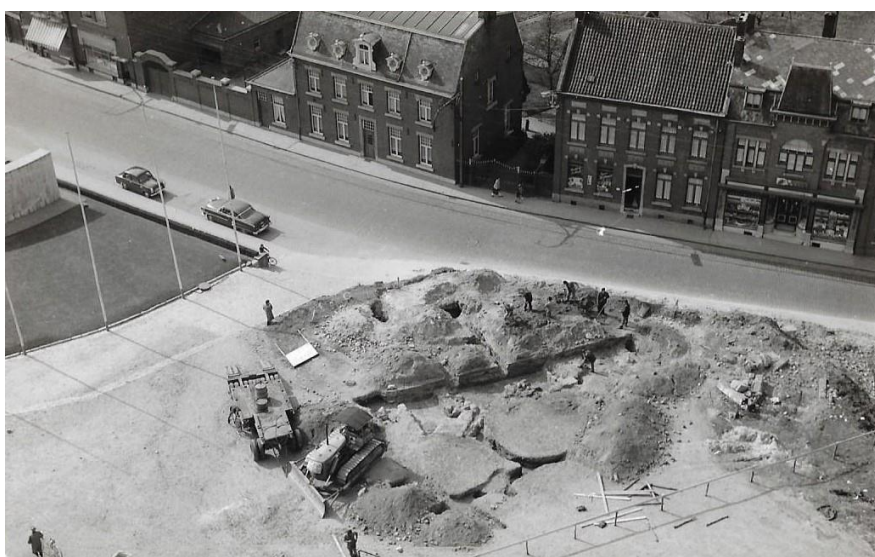
Afb. 238. Opgravingen in 1956 legden de fundamenteën van eerdere kerken bloot.
