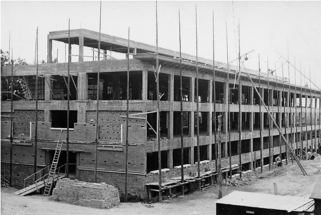
Afb. 253. Lange dennen palen werden gebruikt om de metselsteiger te bouwen. De kroonlijst uit beton is reeds ontsticht, het gevelmetselwerk is in uitvoering.
