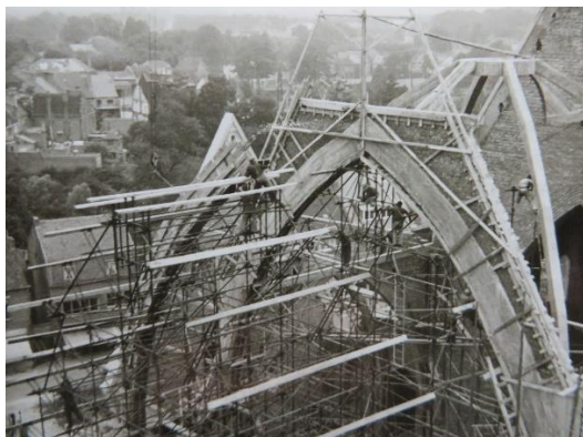
Afb. 178 en 179. Het reigersnest op 22.00 m hoogte is het sluitstuk van de kruisbeuk. De nok van het dak zal op 32.50 m hoogte liggen.
