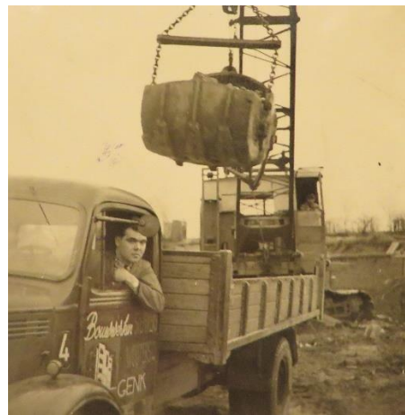
Afb. 100. De grondwerken starten terwijl er 50m verder er nog schapen stonden te grazen. We zien een Chevrolet-Willems, een eigen montage uit 1945 en een Amerikaanse draglinekraan Marion. De uitgegraven grond werd verwerkt in het nieuwe kerkplein en de taluds. Jaren later zag ik als kind nog eens een doodshoofd van de helling rollen toen vanuit de Molenstraat de kronkelende toegangsweg (mijn vader noemde hem de Tourmalet ) werd aangelegd.
