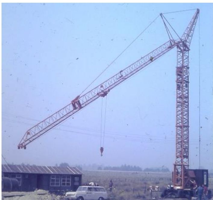
Afb. 409. Montage van een nieuwe bouwkraan Arcomet VK22. De eerste kraan op spoor die de machine- bouwer uit Paal bouwde, op onze vraag.
