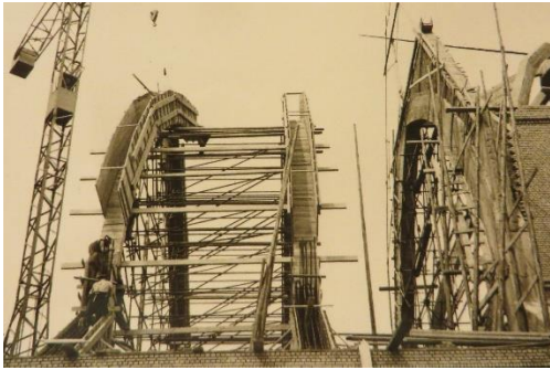
Afb. 180 en 181. Bekisting van de bogen en metselwerk tot aan het dak.
