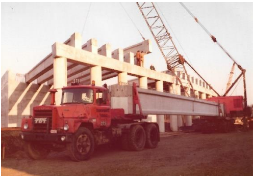
Afb. 480 en 481. Uitzonderlijk transport van de prefabbalken vanuit Lier.
