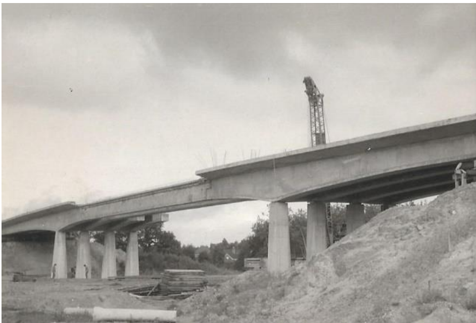
Afb.456. Brug B15. Enkel het dek voor de middenoverspanning dient nog gebouwd te worden.
