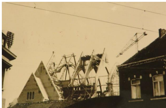
Afb. 194 tot 196. Het metselwerk op de spitsbogen vertoont de openingen voor het gangpad op de zolder. Beneden het zicht vanuit de Stationsstraat, hoek met de Molenstraat. Daar zien we nog net links schoenhandel Brouns en rechts wat ooit Maison Stuelens was en eerder nog een handel in granen.
