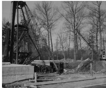
Afb. 314 en 315. Funderingspalen waren een noodzaak, gezien de nabijheid van de rivier Dijle. Hier zien we de ter plaatse gemaakte heipalen en de heistelling van de firma Despriet.
