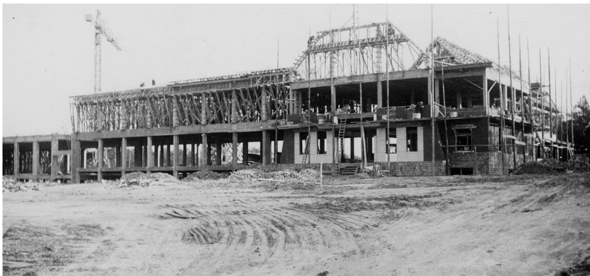
Afb 244. Het betonskelet van het gebouw.
