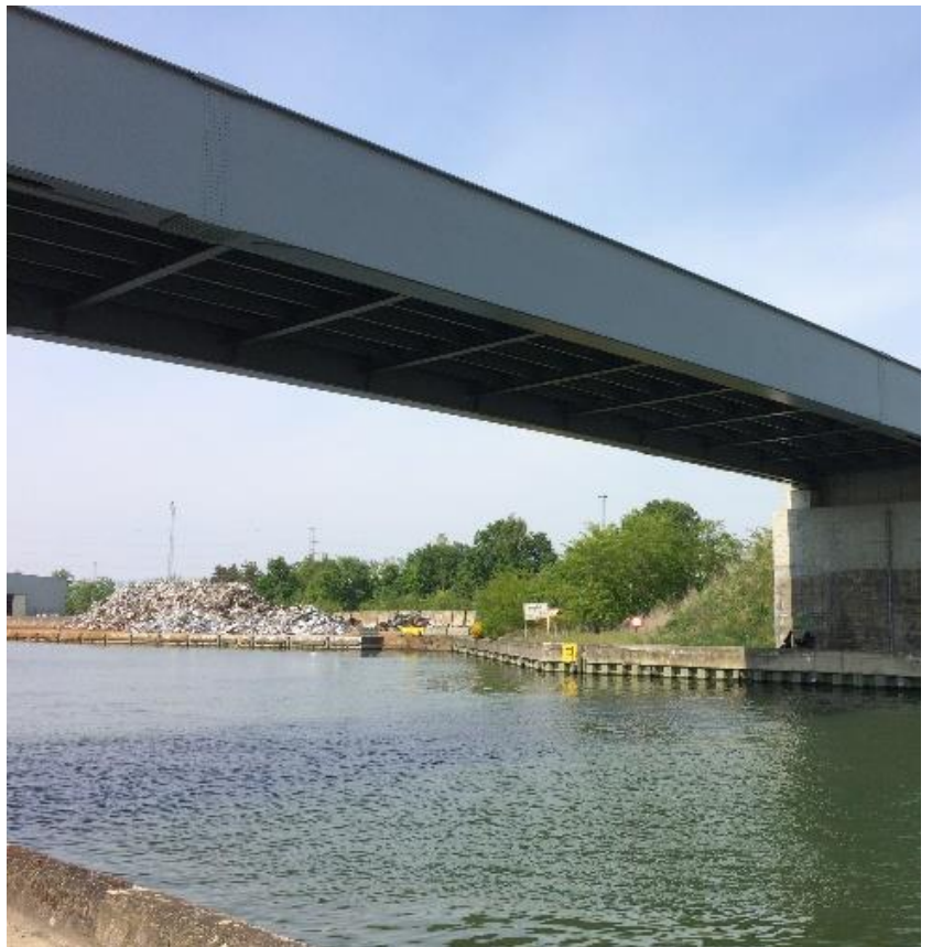
Afb. 284. De brug werd in 2020 naar een hoger niveau gebracht, met behoud van de originele landhoofden.
