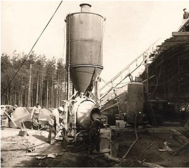
Afb. 353. Brug B51 te Tessenderlo. De betonmolen die een vat (met hermetisch afsluitbaar deksel) vult. Aansluitend wordt de inhoud pneumatisch naar de stortplaats geblazen. Rechts van de grote cementsilo staat een vertikaal opgesteld drukvat, dat de blaascapaciteit moet garanderen. Later zou dit systeem voor openbare werken niet meer toegestaan worden vanwege mogelijke luchtinsluitsels in het beton. Rond 1968 pas zou de hydraulische betonpomp (nu overal gebruikt) op de markt verschijnen.
