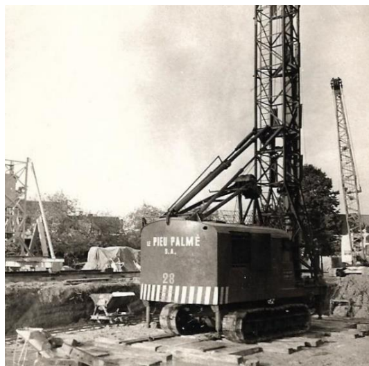
Afb. 376 en 377. Grondwerk en paalfunderingswerken werden parallel uitgevoerd. In de bouwput werd het beton getransporteerd met mijnwagentjes.
