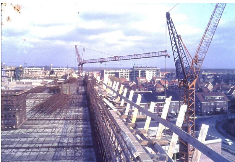
Afb. 462. Voltooiing van de dakrand op de 6e verdieping. Doorheen de topmast van de eerste kraan zien we de St Catharinakerk.
