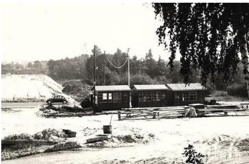
Afb. 419. De werfkantoren met op de achtergrond de omleidingsweg en hele- maal achteraan de grond- werken (100.000 m 3 , inbe- grepen in de aanneming), om het grondverzet van de autostrade na voltooiing van de brug toe te laten.
