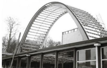
Afb. 330. Het skelet van de constructie tijdens de demontage.
