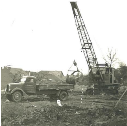
Afb. 100. De grondwerken starten terwijl er 50m verder er nog schapen stonden te grazen. We zien een Chevrolet-Willems, een eigen montage uit 1945 en een Amerikaanse draglinekraan Marion. De uitgegraven grond werd verwerkt in het nieuwe kerkplein en de taluds. Jaren later zag ik als kind nog eens een doodshoofd van de helling rollen toen vanuit de Molenstraat de kronkelende toegangsweg (mijn vader noemde hem de Tourmalet ) werd aangelegd.
