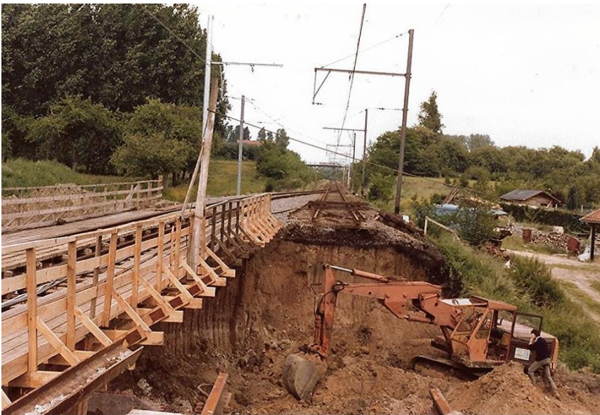
Afb. 502. Na het bouwen van een voorlopige brug in december 1980 en sloop van de oude brug worden de grondwerken voor de nieuwe gestart.
