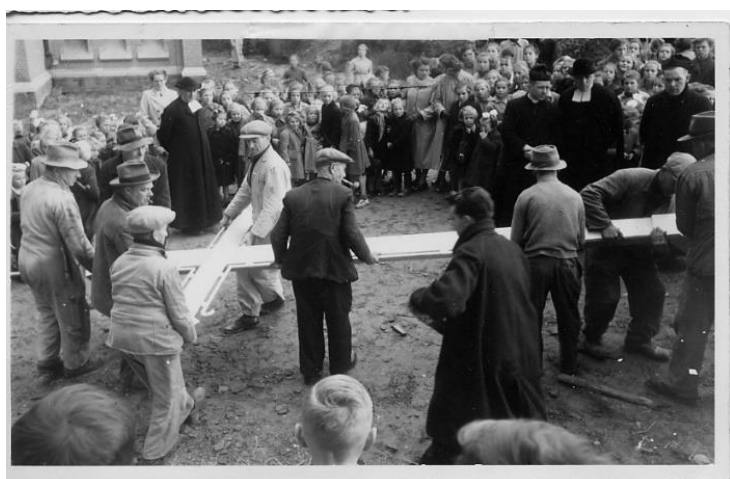
Afb. 217. Zeven arbeiders brengen het smeedijzeren kruis op de plaats van waaruit het zal vertrekken richting torenspits. Albert Steyfkens (met sigaartje) leidt de werkzaamheden. De geestelijken (broeders en kapelaans) houden de kijklustige schoolkinderen op afstand.
