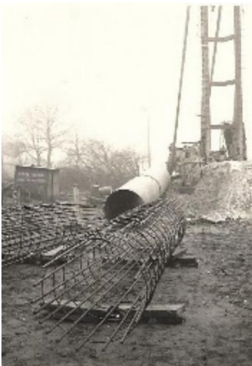
Afb. 428. Brug B18. De landhoofden werden gefundeerd op zogenaamde verloren putten Ø 122cm met een diepte van 14m. Uitgevoerd door onderaannemer Socofonda, die eerder ook de funderingspalen voor het Atomium realiseerde.
