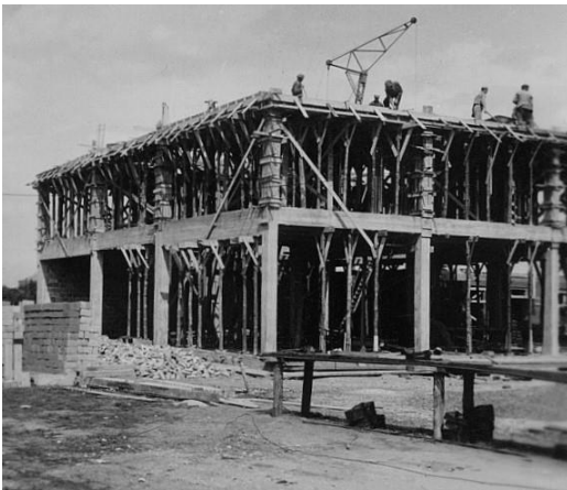
Afb. 265 en 266. Betonneren van het dek in Beringen.
