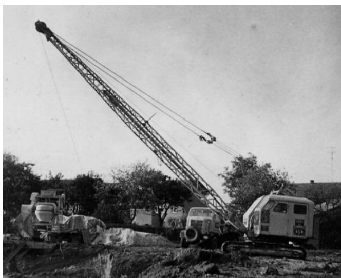
Afb. 373. Grondwerken met de Nordest-dragline en Federal Autocar vrachtwagen. (zie ook afb. 375)
