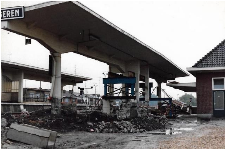
Afb. 511. Na vrijmaken van de funderingen wordt een 30m lange betonnen luifel omhoog gevijzeld.
