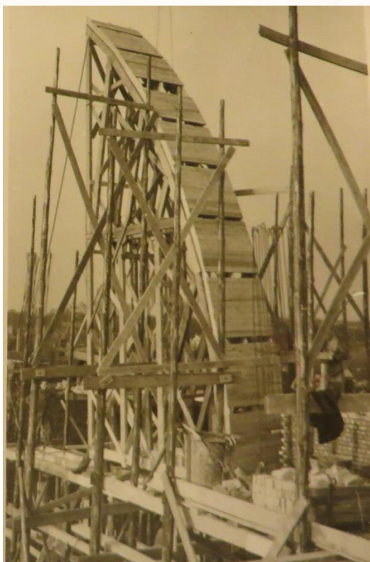
Afb. 159. De zijbeuken worden als eerste opgetrokken om steun te bieden aan de latere constructie van de kruisbeuk.
