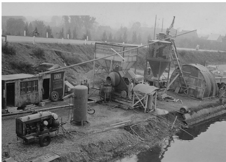
Afb. 279. Op de voorgrond de compressor met drukvat: het beton werd pneumatisch naar de stortplaats gestuwd. De lange houten (liggende) paal met dwarsplank droeg één lamp, net boven de betonmolen.
