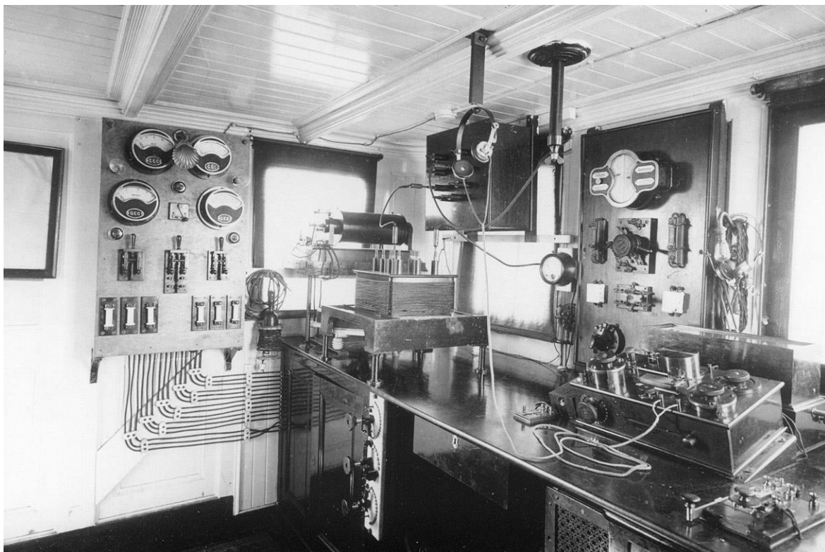
Radio-installatie van een mailboot. De foto dateert van 1925.
