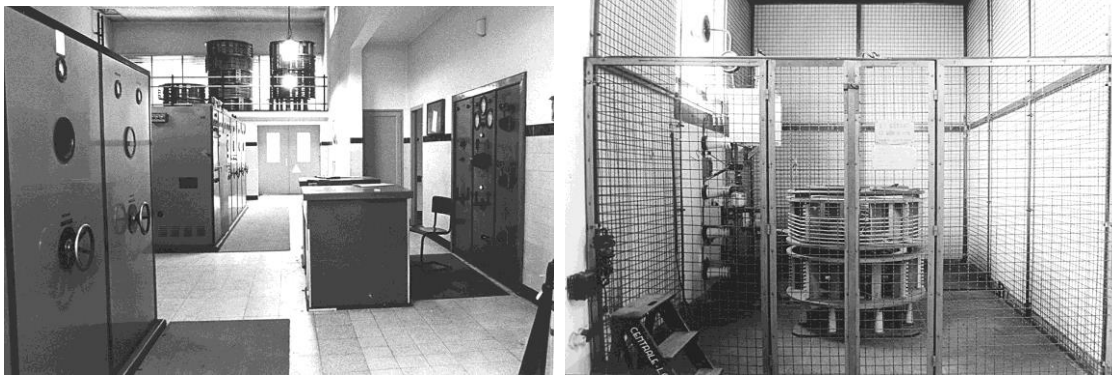
SCRE: zenders en antenne-aanpassingsnetwerk voor de 500 kHz-band
