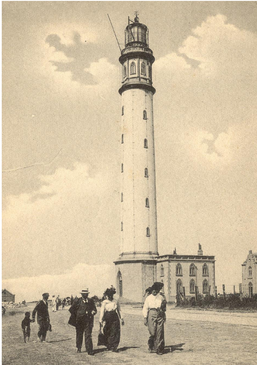
AR De vuurtoren, opgericht aan de oostkant van de havengeul, werd in dienst gesteld in 1860 en sneuvelde tijdens de Eerste Wereldoorlog
